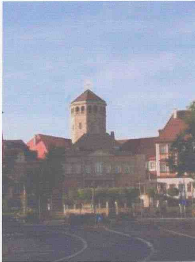
Blick auf das Kinderhaus St. Vinzenz; dahinter der Schlossturm
