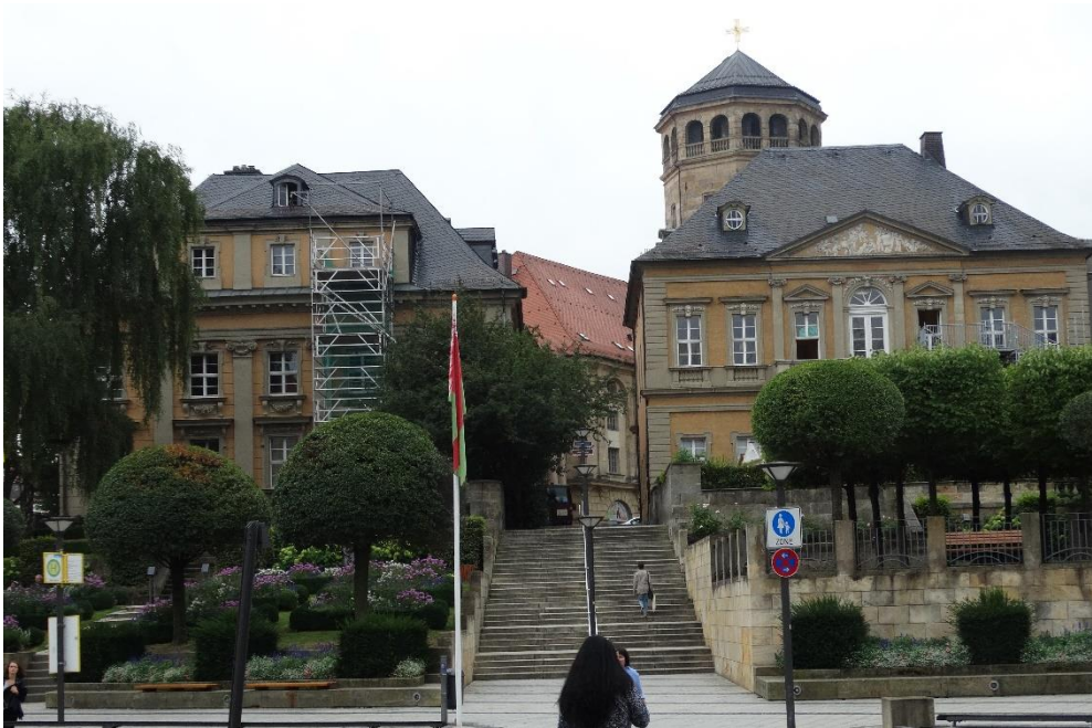
Blick auf das Kinderhaus St. Vinzenz; dahinter der Schlossturm
